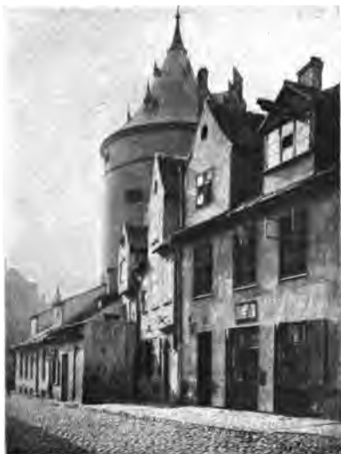
Abb. 4. Ansicht des Sandturmes von der Turmstraße her. (Nach einer Aufnahme des Architekten E. Kupffer.)
